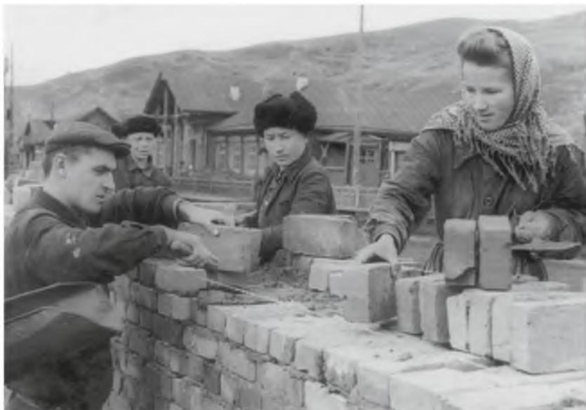
ряд из силикатного выкладывается уже «тычком», поперек стены, перевязка называется. И так далее, снова по новой.
