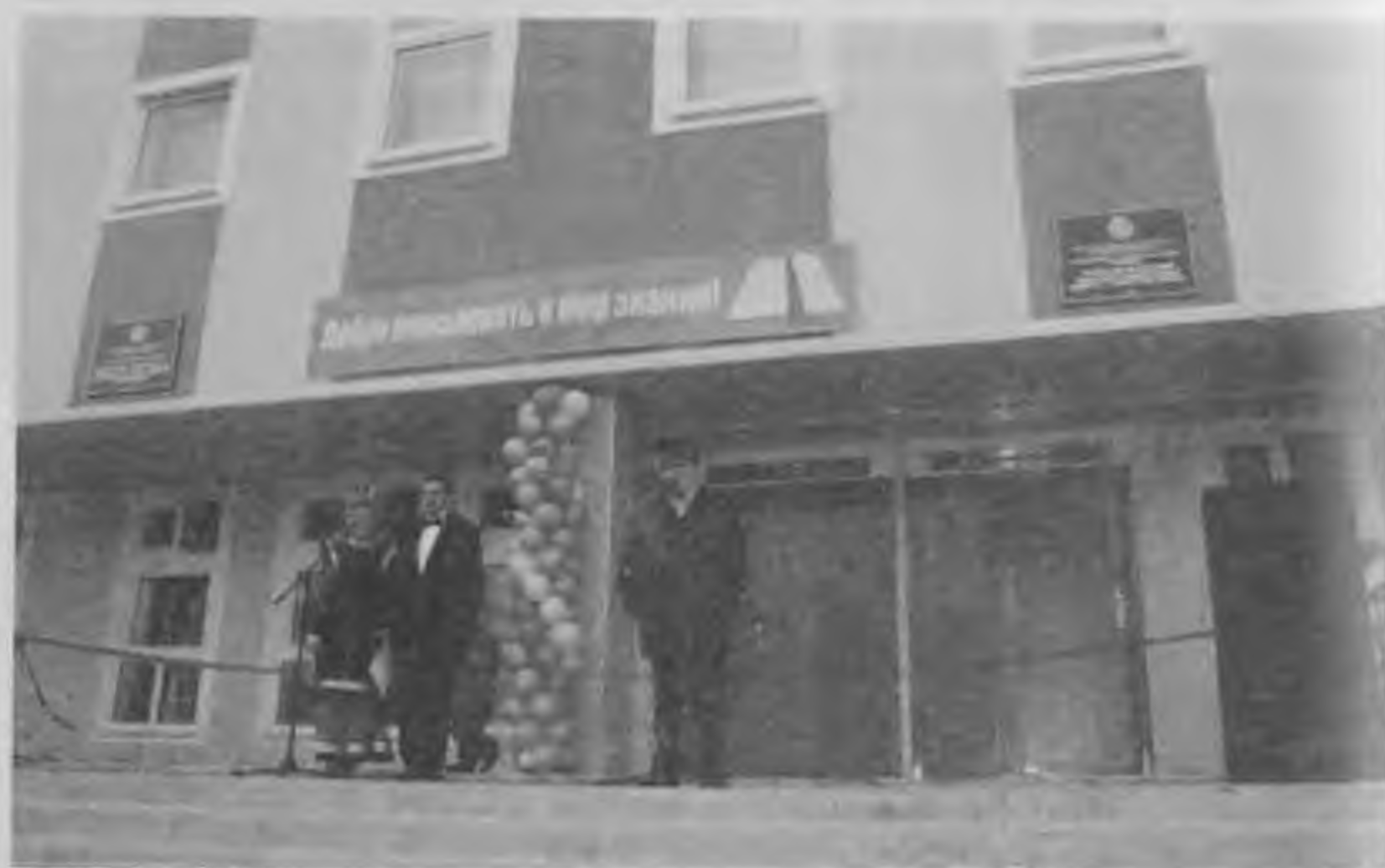
На строительство школы в Акташе Улаганского района было направлено 380,5 млн. рублей. Контроль за ходом федерального финансирования этого объекта осуществлял лично Председатель Правительства России В.В. Путин. Фото: 01.10.2010 года
