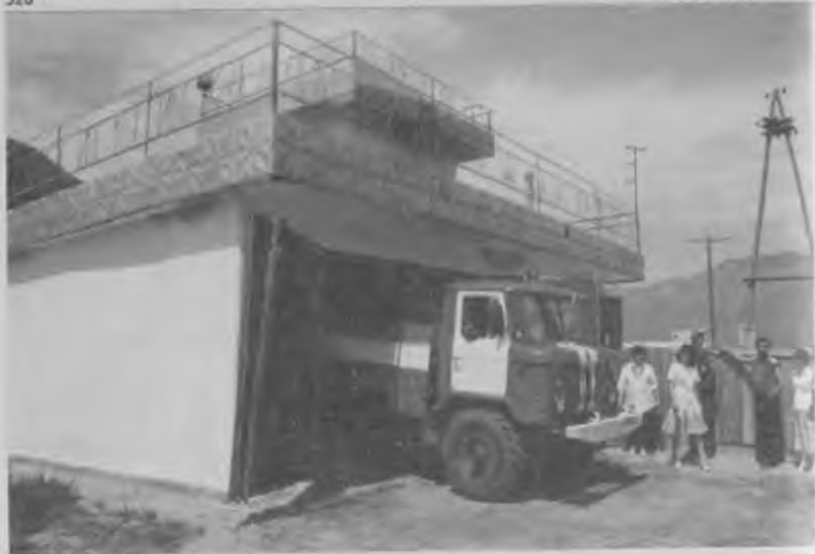
В июле 2009 года в с. Иня Онгудайского района построен пожарный пункт
