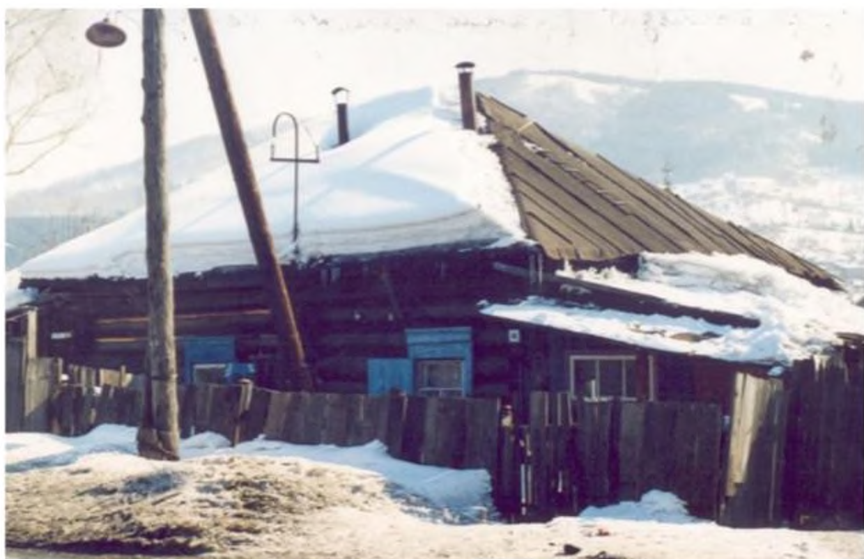
Здание бывшей начальной школы №8.
