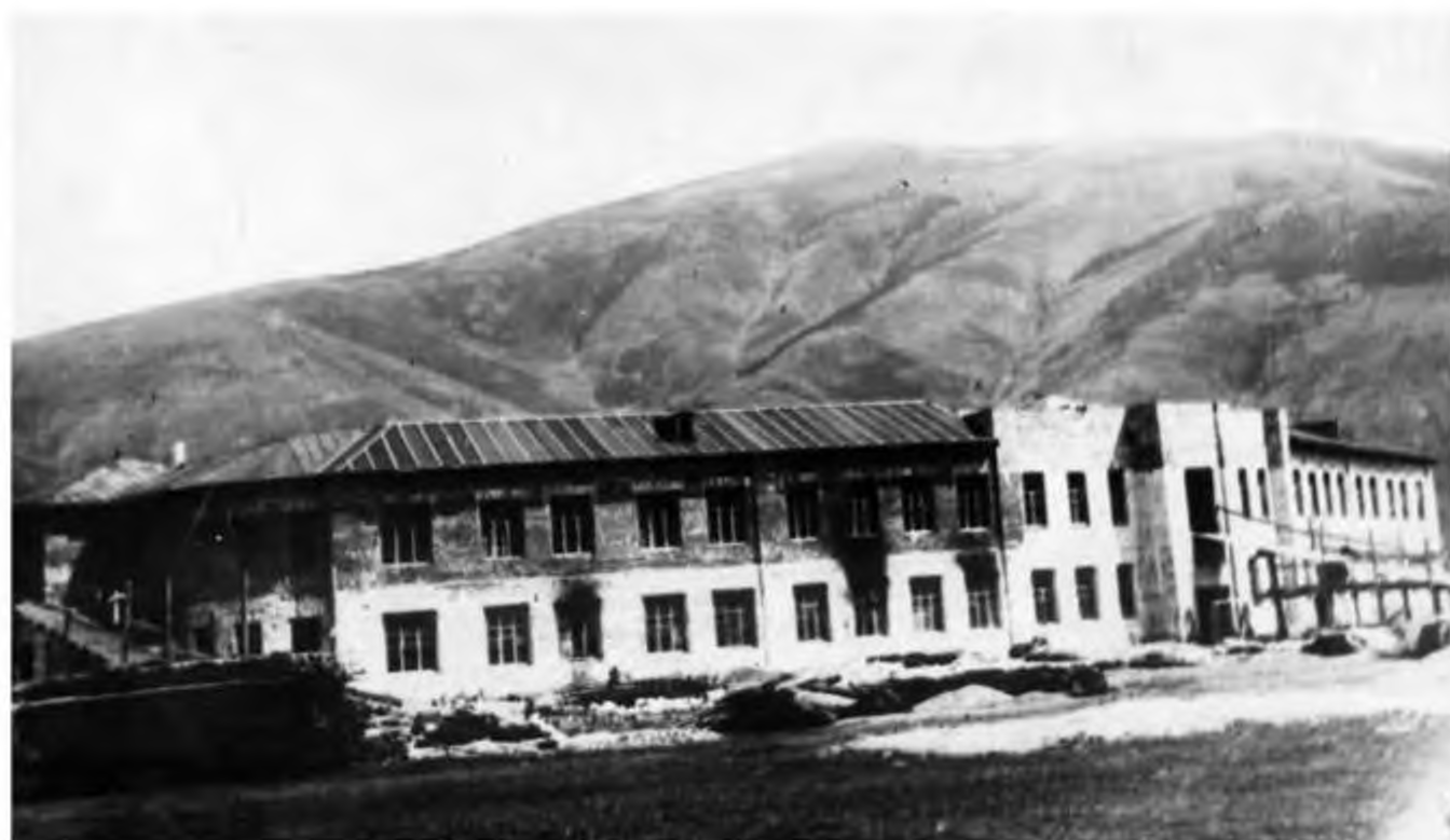
Строительство областной больницы.
