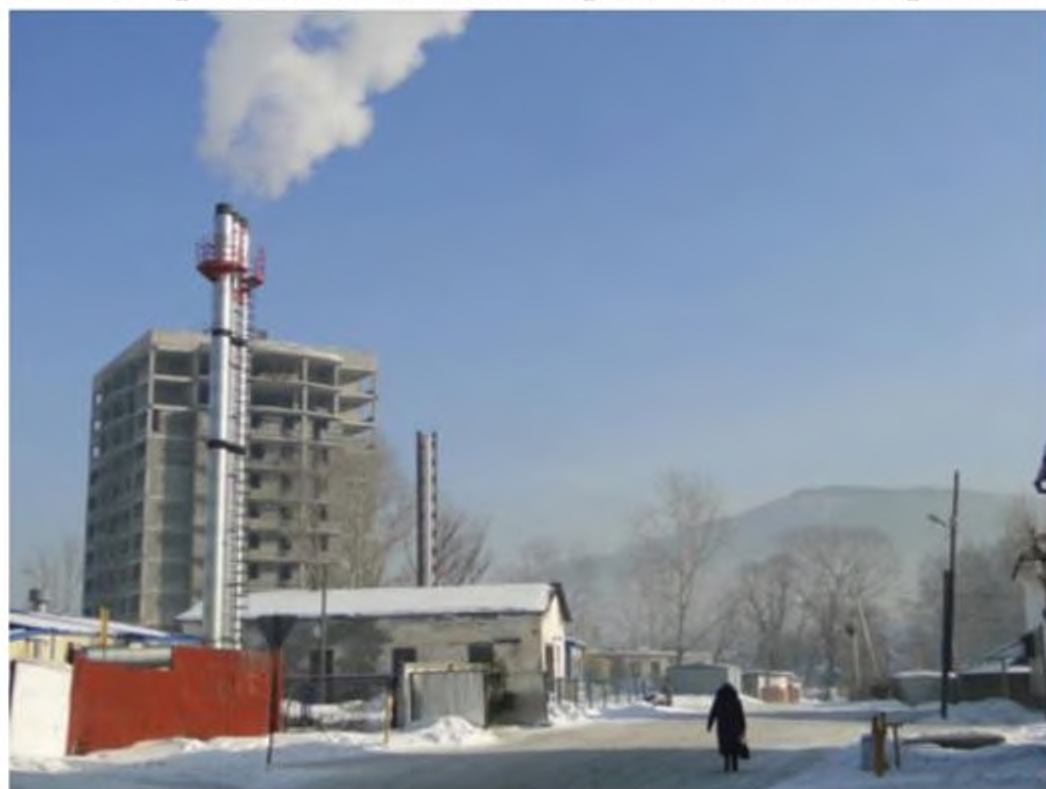
Газовая котельная в районе торгового центра «Ткацкий». Фото 2009 года.
