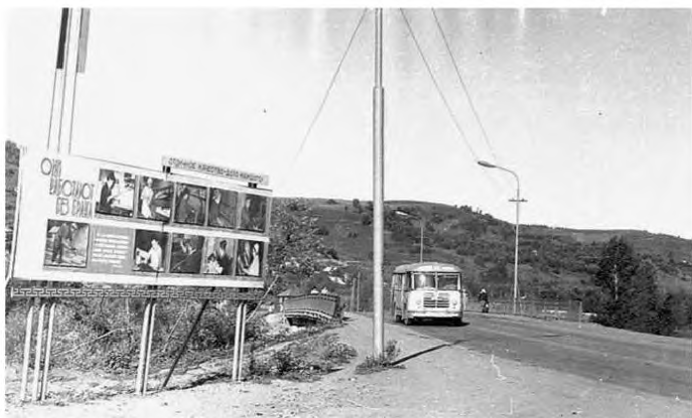
Мост через реку Майма – окраина Горно-Алтайска.
