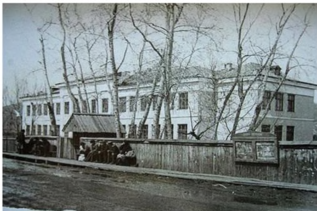
Здание школы № 12, рядом остановка автобуса. Фото 50-х годов XX века.
