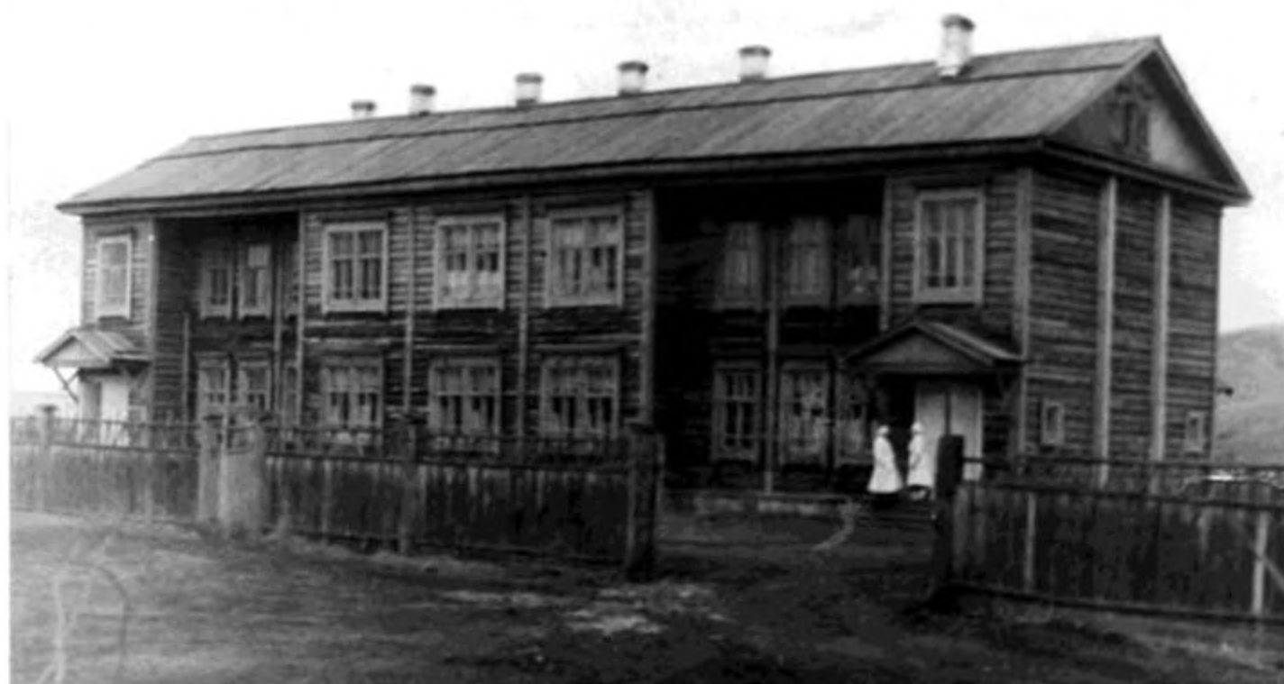
Здание поликлиники. Фото 1932 года.
