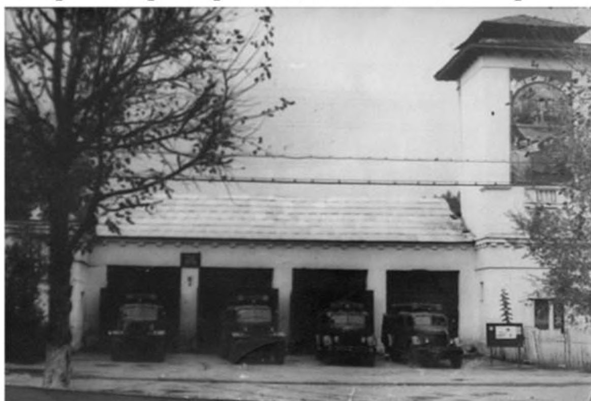
Здание пожарной охраны. Фото 50-х годов XX века.
