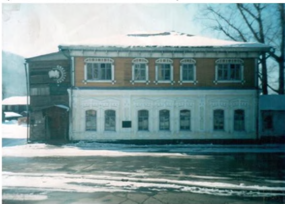
Ещё одно здание первой школы – современный НИИЯЛ.
