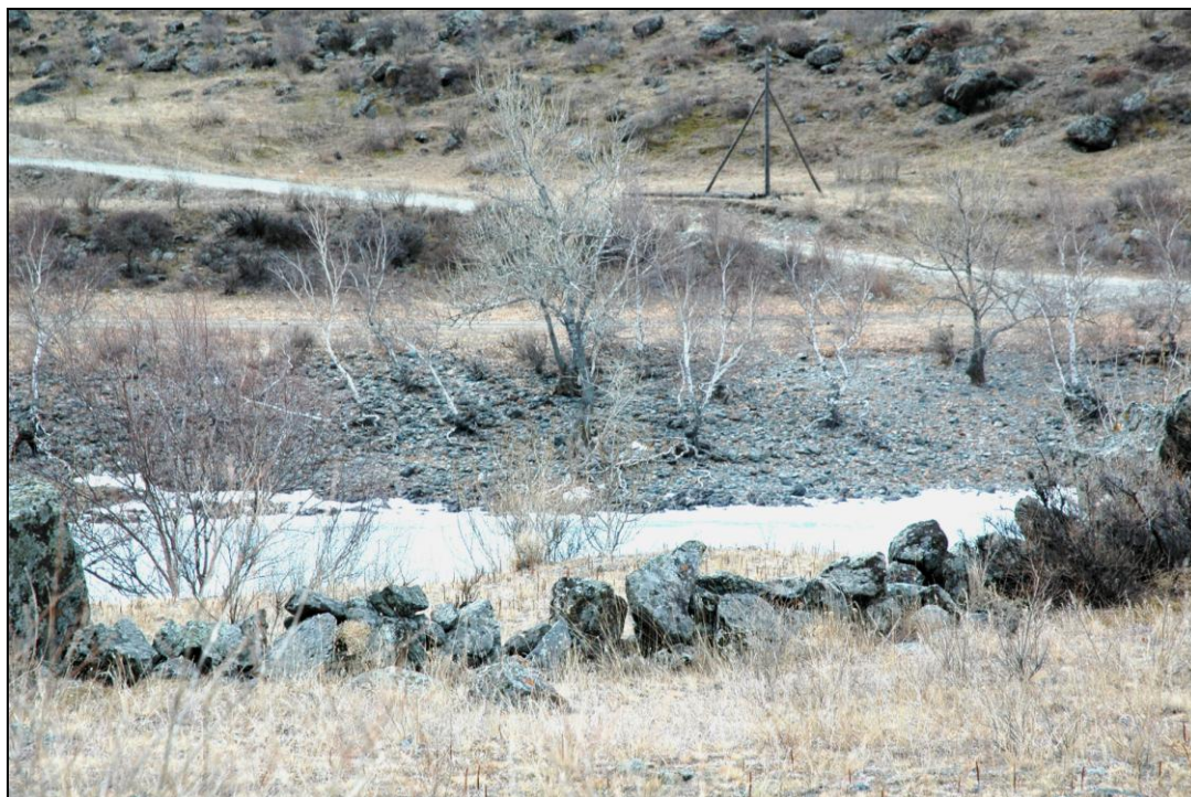
Рис.4 Вид юго-восточной стены укрепления напротив Уйтту-Кай.
